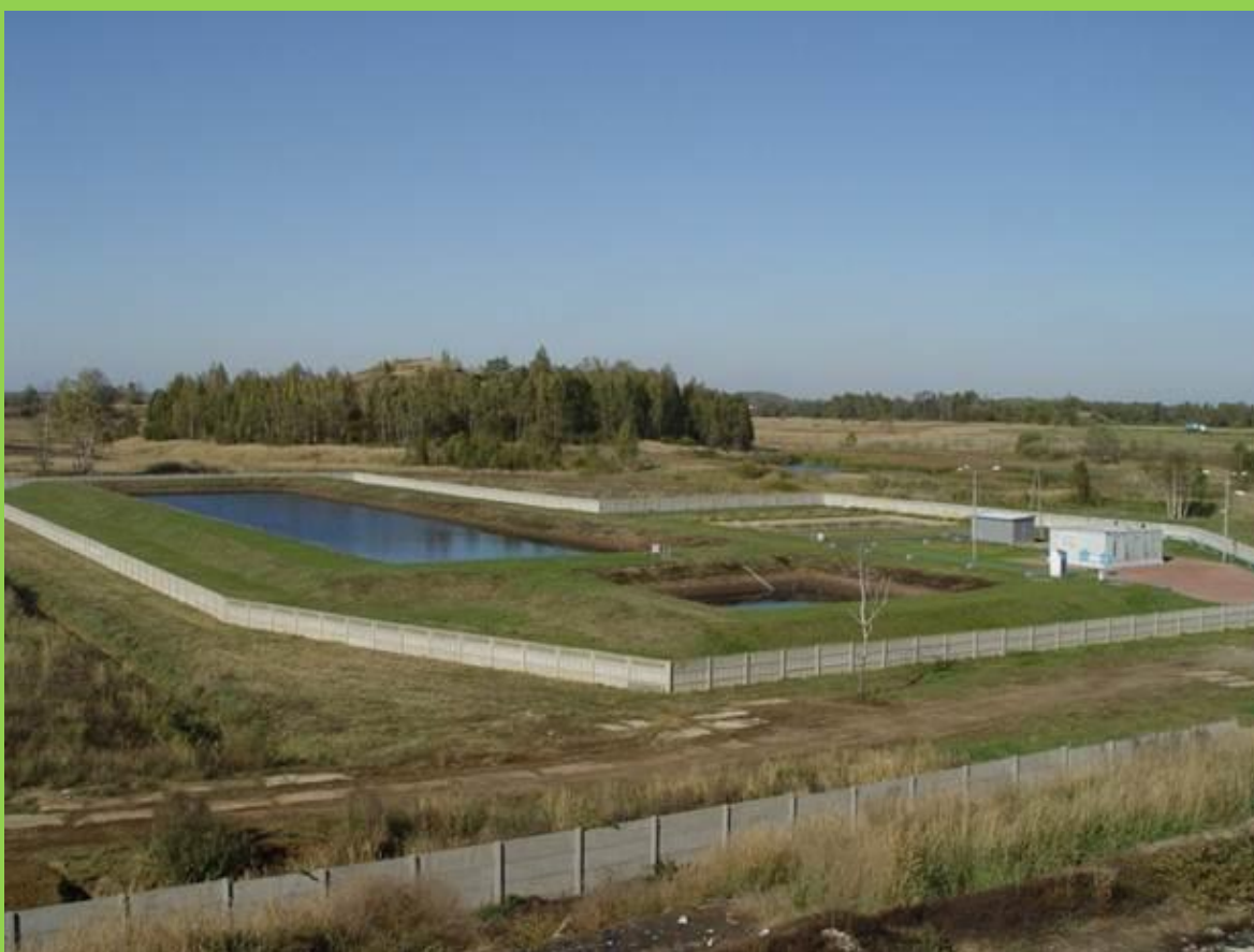
Oczyszczalnia odcieków oparta o technologię odwróconej osmozy, o przepustowości dobowej 80m 3 .
