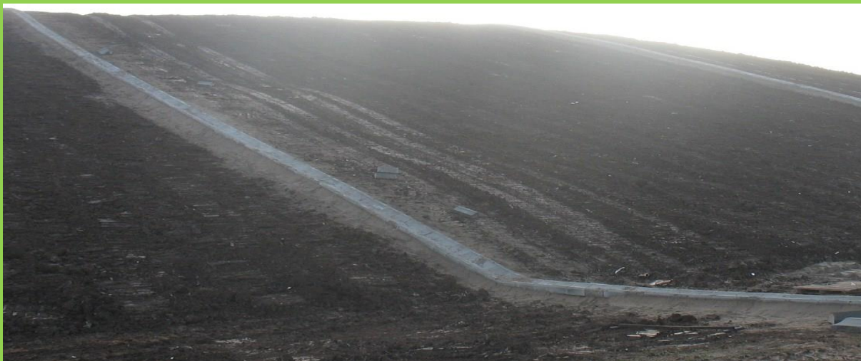
Układ sączków i zbierniczy oraz rowów opaskowych dla odcieków składowiska
